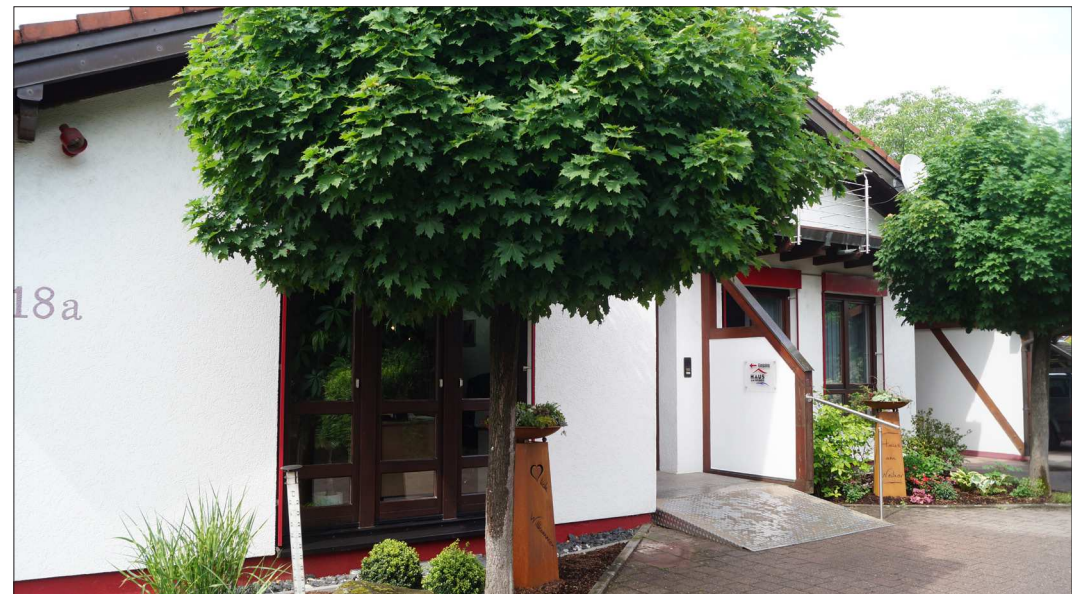
Blick von außen auf die Tagespflegestätte „Haus am Weiher“.
